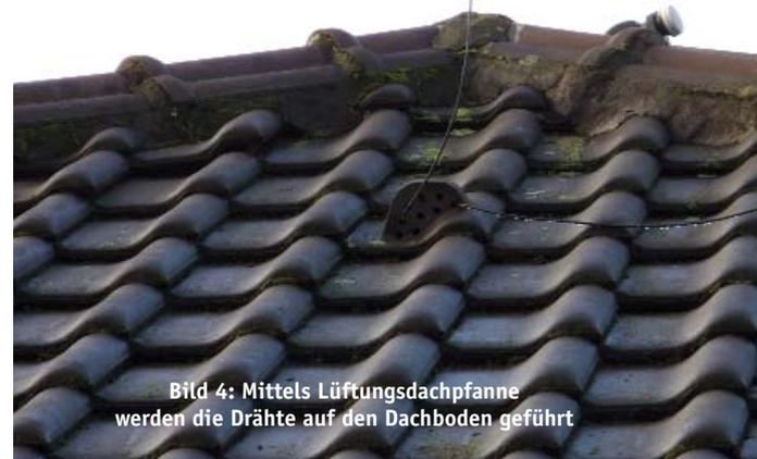
**Bild 4:** Mittels Lüftungsdachpfanne werden die Drähte auf den Dachboden geführt
