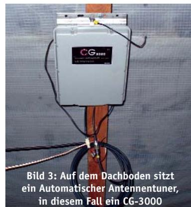
**Bild 3:** Auf dem Dachboden sitzt ein Automatischer Antennentuner, in diesem Fall ein CG-3000
