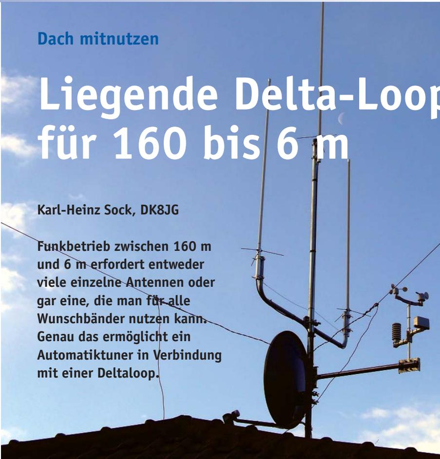
**Bild 1:** Der Mast wird mehrfach genutzt: als Träger für UKW-Antennen als auch zur Abspannung der Loop
